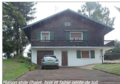
Maison style chalet, bois et faible pente de toit
