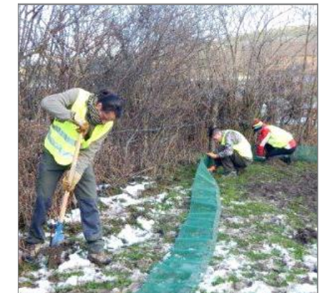
Lycéens contribuant à la pose du dispositif
