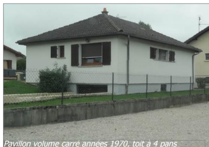
Pavillon volume carré années 1970, toit à 4 pans
