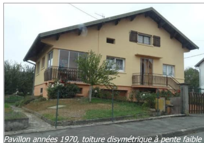
Pavillon années 1970, toiture dissymétrique à pente faible
