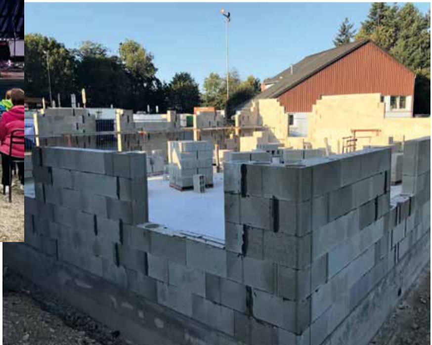
Travaux de réhabilitation (démolition / reconstruction) des locaux sociaux de la déchetterie de Fêche-l'Eglise
