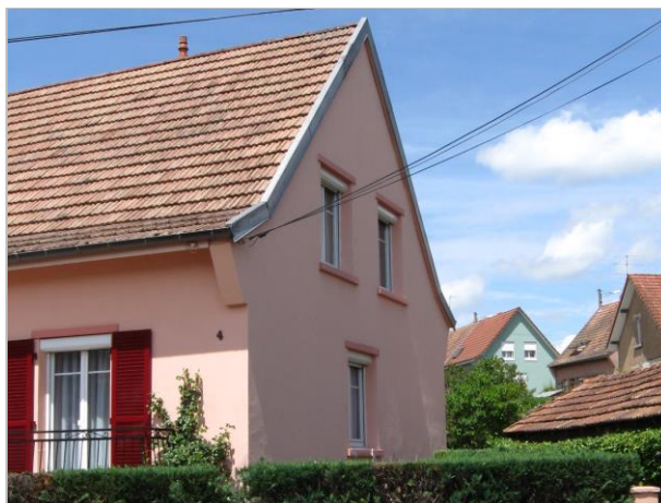
Exemple de retroussis de toiture à Belfort
