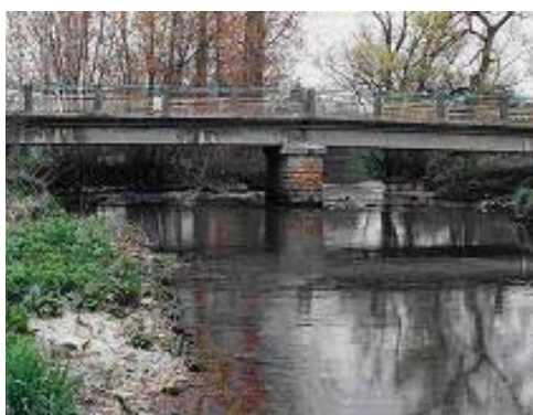
Pont de la RD44 à JONCHEREY
